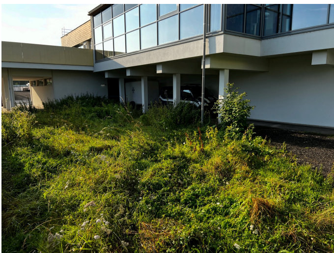
Zwischenlösung Einsatzfahrzeuge, neben Hallenbad seit 2018
